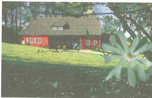
Sanierung ist gesichert: Das durch den vergangenen strengen Winter beschädigte Dach des Böckstiegel-Hauses soll noch in diesem Jahr repariert werden.
